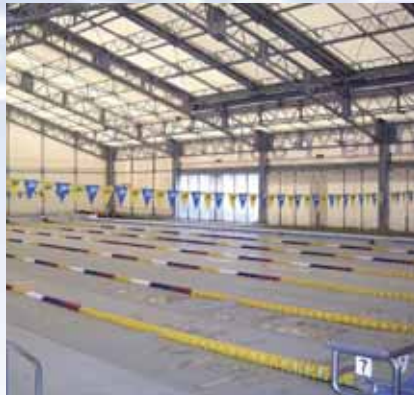
プールの様子
